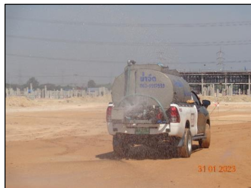
รูปที่ 2-2 การฉีดพรมน้ำในพื้นที่ก่อสร้างที่มีการฟุ้งกระจายของฝุ่น
