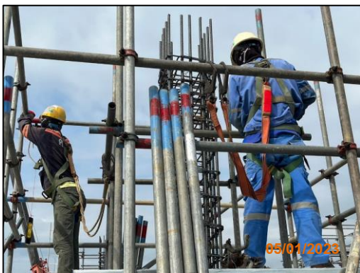
รูปที่ 2-62 เชื่อมขันนิรภัยสำหรับการทำงานบนที่สูง
