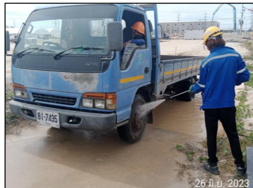
รูปที่ 2-6 พื้นที่ล้างล้อสำหรับรถที่ออกจากโครงการ
