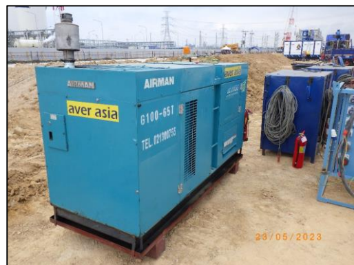
รูปที่ 2-20 ถาดรองน้ำมันเครื่องบริเวณเครื่องกำเนิดไฟฟ้าดีเซล
