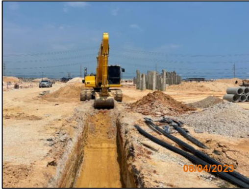
รูปที่ 2-30 กิจกรรมขุดวางระบายน้ำในพื้นที่โครงการ
