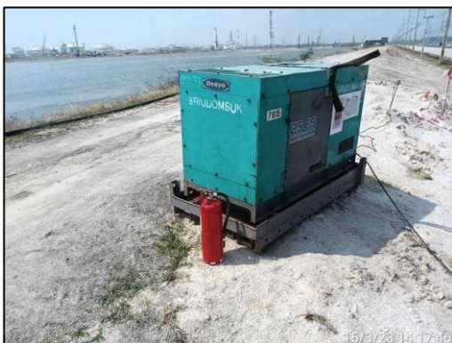
รูปที่ 2-20 ถาดรองน้ำมันเครื่องบริเวณเครื่องกำเนิดไฟฟ้าดีเซล
