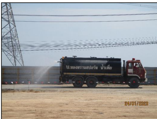
รูปที่ 2-2 การฉีดพรมน้ำในพื้นที่ก่อสร้างที่มีการฟุ้งกระจายของฝุ่น
