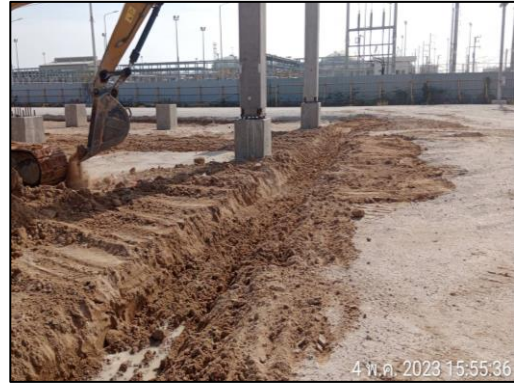
รูปที่ 2-30 กิจกรรมขุดวางระบายน้ำในพื้นที่โครงการ
