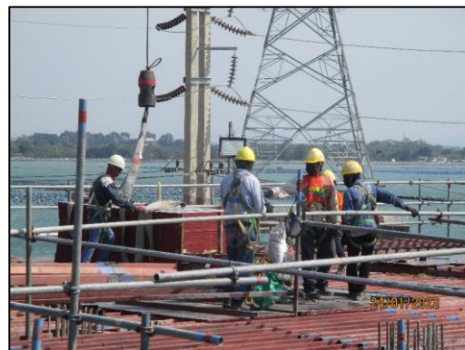
รูปที่ 2-62 เชื่อมขันนิรภัยสำหรับการทำงานบนที่สูง
