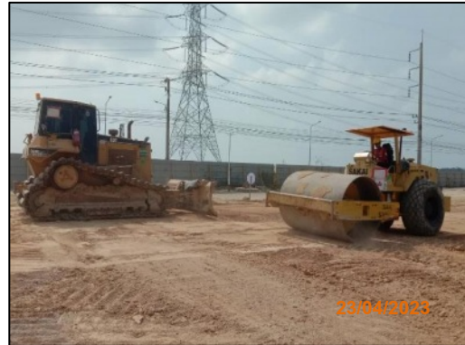
รูปที่ 2-1 การบดอัดดินให้เรียบรียก่อนเปิดพื้นที่ส่วนอื่น
