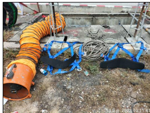
พัดลมระบายอากาศและเชือกช่วยชีวิต
