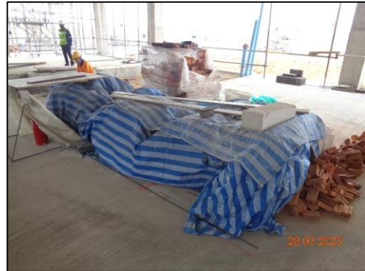
รูปที่ 2-4 ปิดคลุมวัสดุที่อาจก่อให้เกิดการฟุ้งกระจายของฝุ่นละออง
