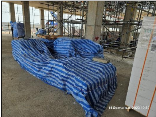
รูปที่ 2-4 ปิดคลุมวัสดุที่อาจก่อให้เกิดการฟุ้งกระจายของฝุ่นละออง
