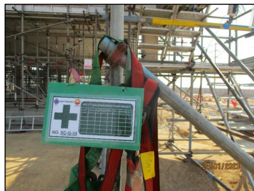
รูปที่ 2-63 การตรวจสอบนั่งร้านก่อนใช้งาน
