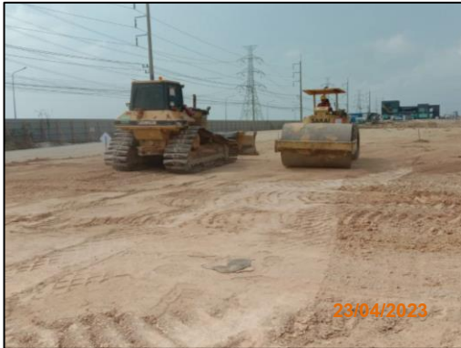
รูปที่ 2-1 การบดอัดดินให้เรียบรียก่อนเปิดพื้นที่ส่วนอื่น
